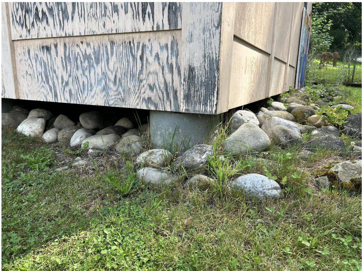
Sockel und Punktfundamente (18 Stk.)
