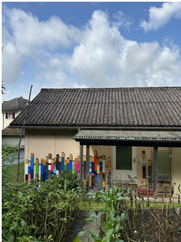
Asbesthaltiges Dach aus Welleterit: Fläche 120 m 2
