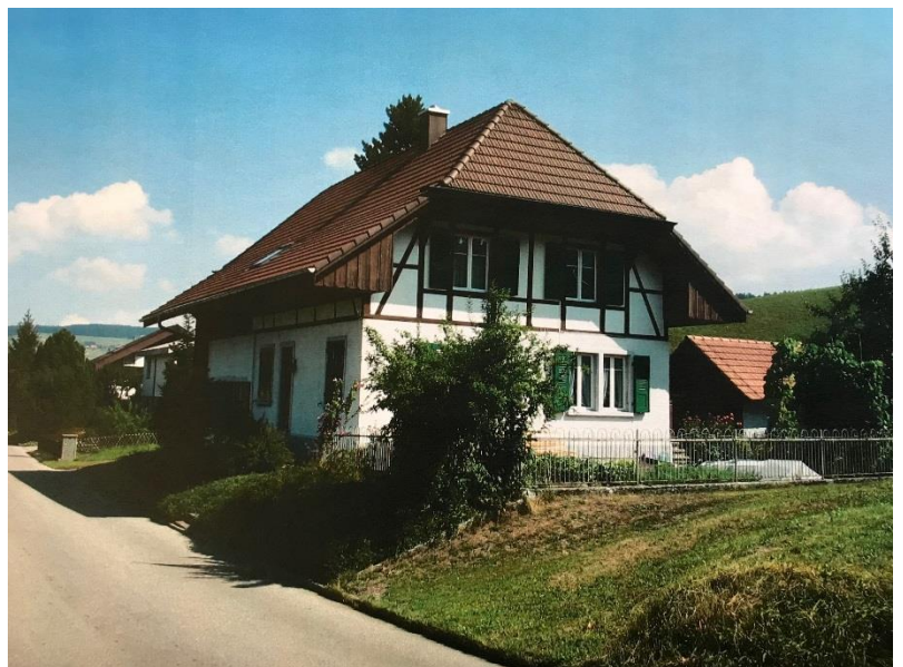
Das Haus vor dem Umbau
